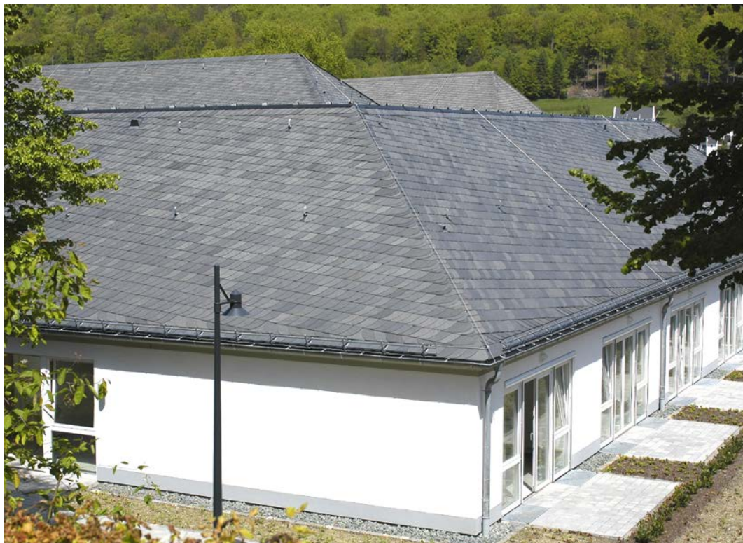
Abb. 1.1 und 1.2: Schieferdächer sind geneigte Dächer mit regensicherer Deckung.
